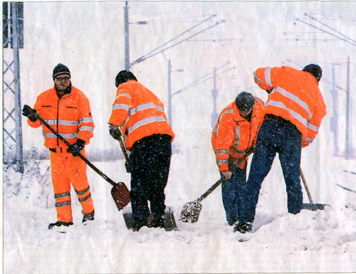
Räumarbeiten auf der Bahnstrecke Stralsund-Berlin. Nach Informationen aus Bahn-Kreisen sollen in den vergangenen Wochen Beschäftigte zu Dumping-Löhnen gearbeitet haben. Foto: oh
